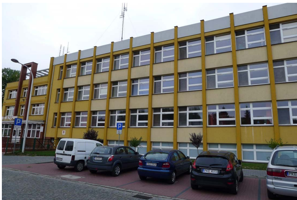
Ryc.2. Widok przebudowywanego budynku Szpitala w Kępnie od ulicy Władysława Sikorskiego
