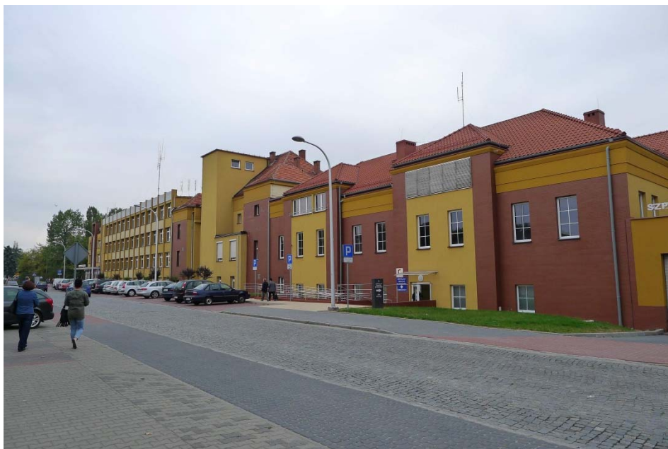
Ryc.4. Widok przebudowywanego budynku Szpitala w Kępnie od ulicy Władysława Sikorskiego
