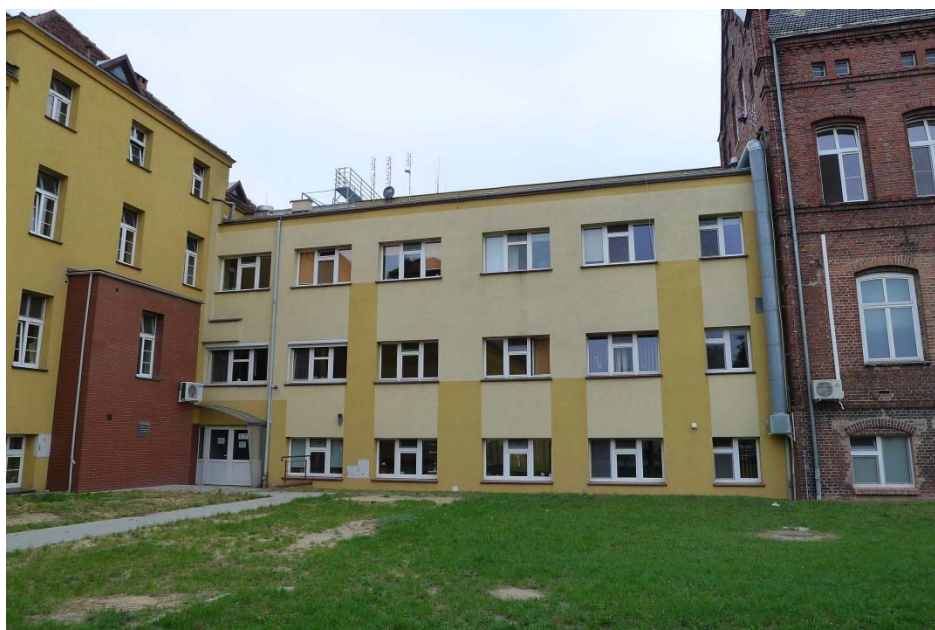
Ryc.5. Widok przebudowywanego budynku Szpitala w Kępnie od strony dziedzińca wewnętrznego
