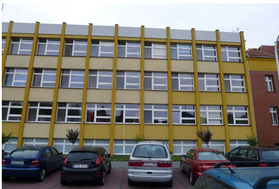
Ryc.3. Widok przebudowywanego budynku Szpitala w Kępnie od ulicy Władysława Sikorskiego
