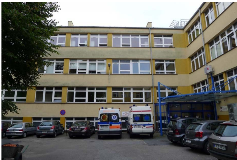
Ryc.6. Widok przebudowywanego budynku Szpitala w Kępnie od strony dziedzińca wewnętrznego
